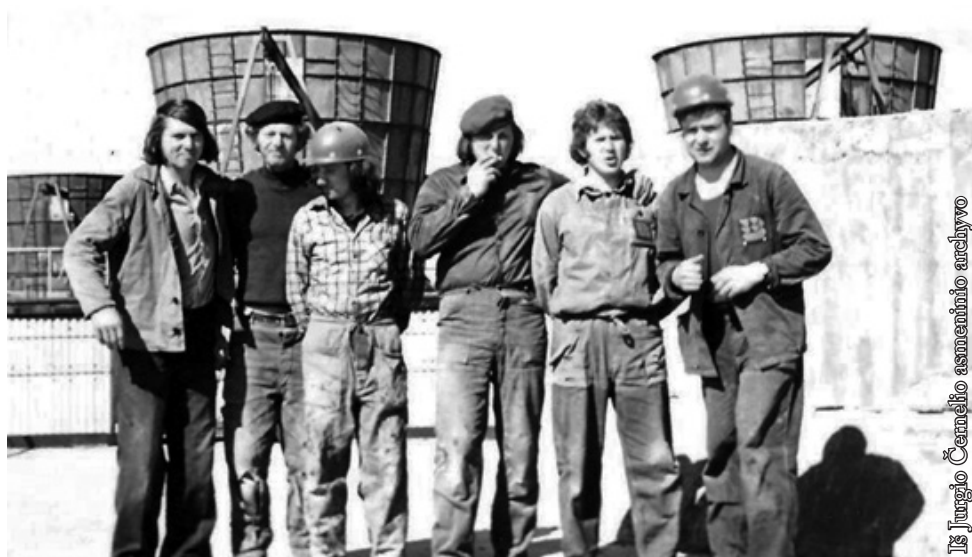
1975 m. Rybnike. Elektrinės statyba
