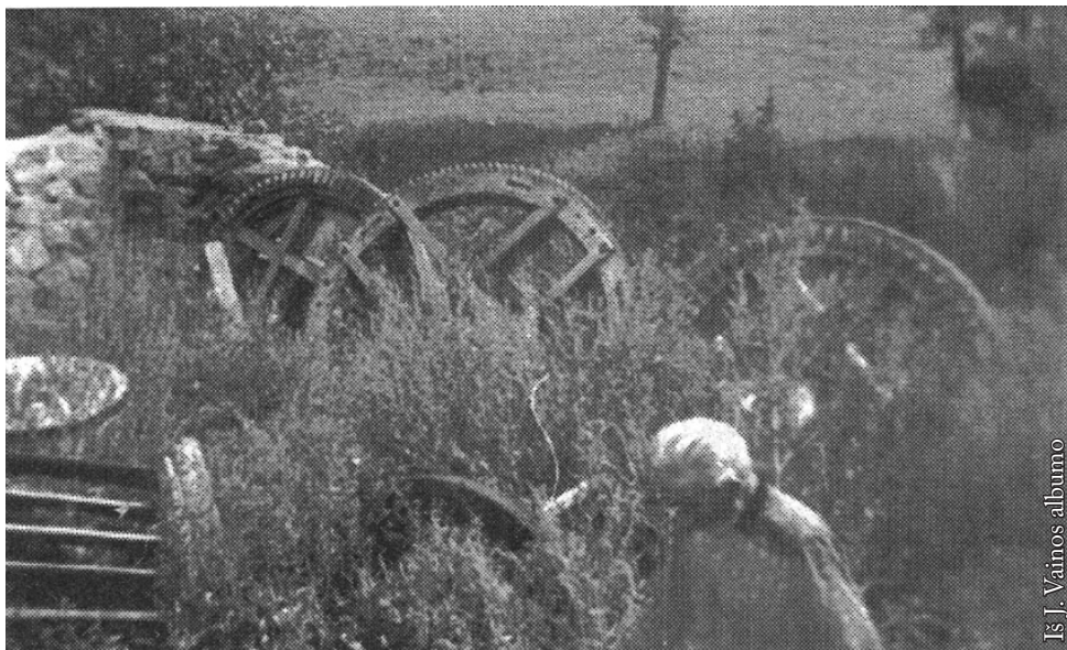
Dusnyčios vandens malūno ratai 1972 m.
